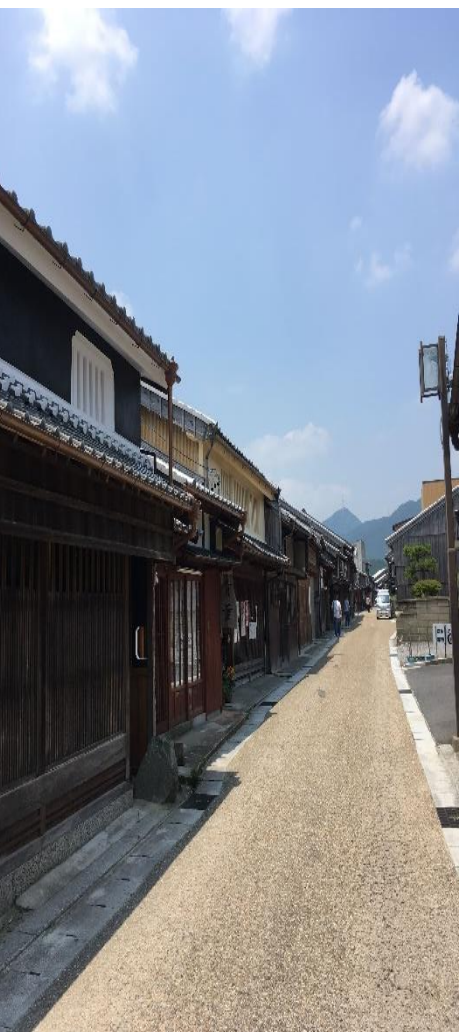
街道には電線・電柱は一切ありません。
